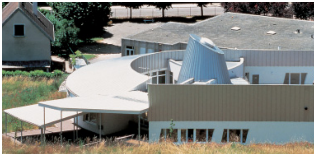
De daken en de verhoogde borstweringen in de gevel werden bekleed met hetzelfde materiaal: matgrijs roestvast staal.
