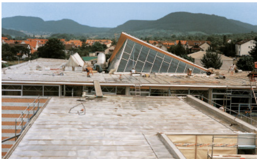
De roestvaststalen dakbedekking met gelaste naden vóór het aanleggen van de daktuin (rechts) en erna (uiterst rechts).
