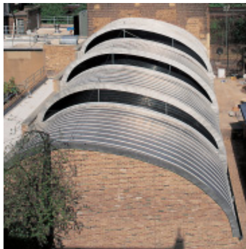
Roestvast staal werd gebruikt voor de buitenhuid van dit ongebruikelijke dak.
