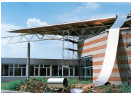
De roestvast stalen rollen werden ter plaatse op maat gesneden.
